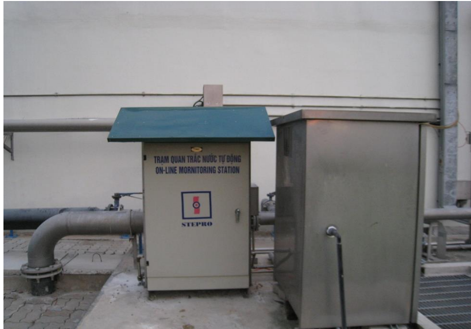
Trạm quan trắc lắp đặt tại Cty Bia Châu Á Thái Bình Dương, bên cạnh là thiết bị lấy mẫu tự động
